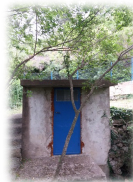
Objekat iznad kaptaze Čanj
